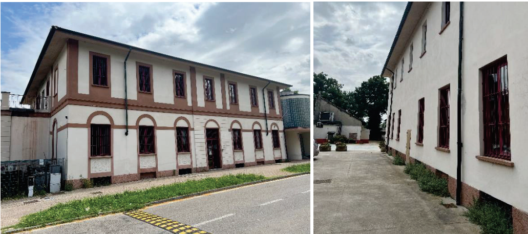
Foto facciate esterne
