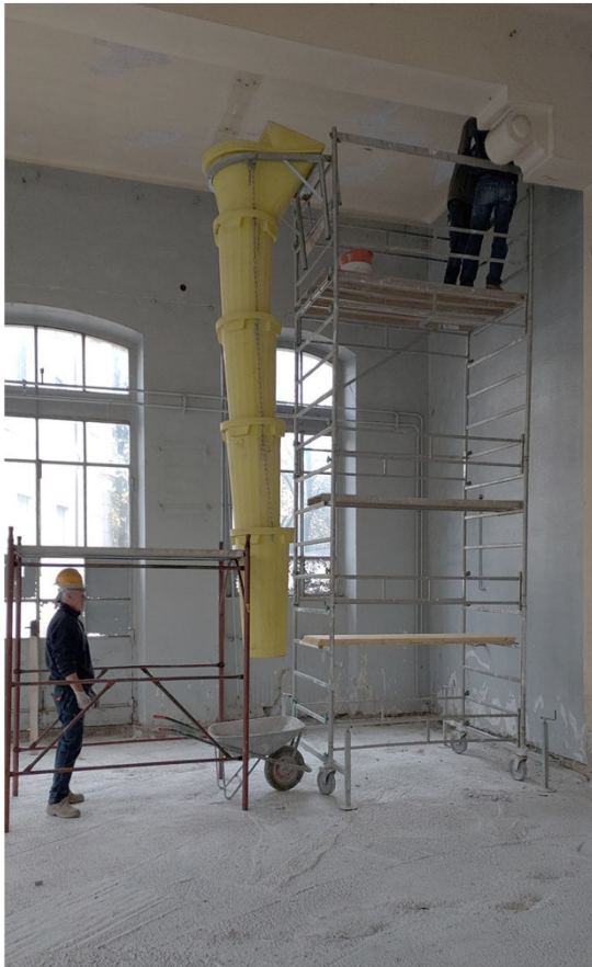
Demolizione solaio Perret
