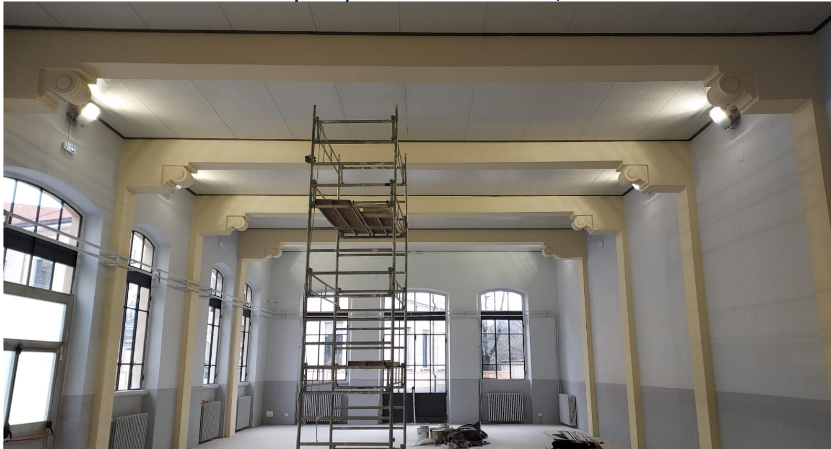
Interno palestra con nuovo controsoffitto
