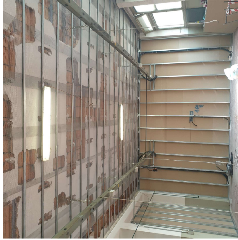
Pareti nuove aule in fase di realizzazione
