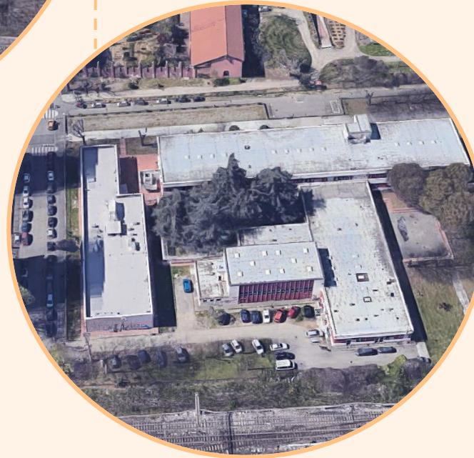
L'edificio è situato in zona Lambrate a Milano. E' un edificio prefabbricato con copertura piana con rivestimento in guaina in pvc. A seguito di ripetute infiltrazioni
