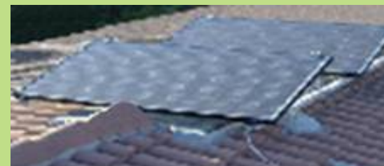
Pannelli non correttamente integrati
