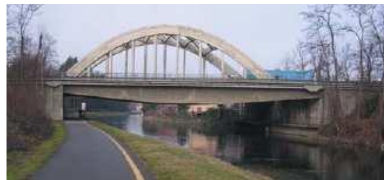
Bernate Ticino: ponte autostradale sul Naviglio
